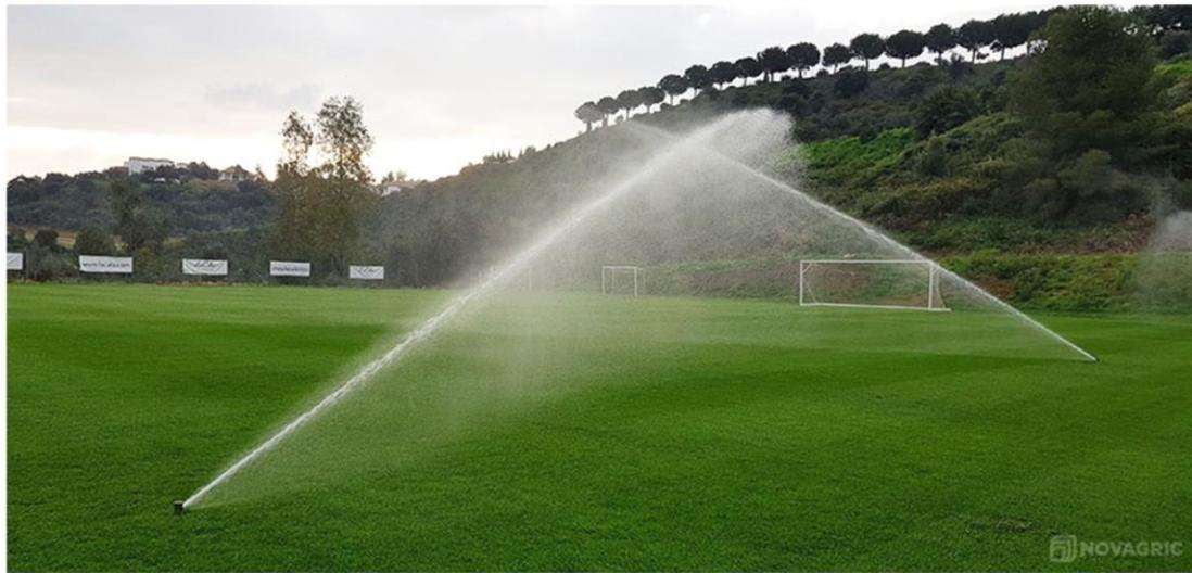
Automatización del riego de campos de fútbol y conversión a un sistema inteligente: al tener el sistema integrado con la plataforma de reservas, se realizan microrriegos al inicio de cada reserva del campo de fútbol, para así disponer siempre de las mejores condiciones. Además se controla el tiempo de riego en función del uso al que vaya a estar destinado la reserva (entrenamiento, partido...), ahorrando agua en las instalaciones.
